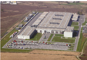
MAN Nutzfahrzeuge, Werk Krakau Werkstrukturplanung, Generalplanung Bau, Gesamtprojektmanagement
